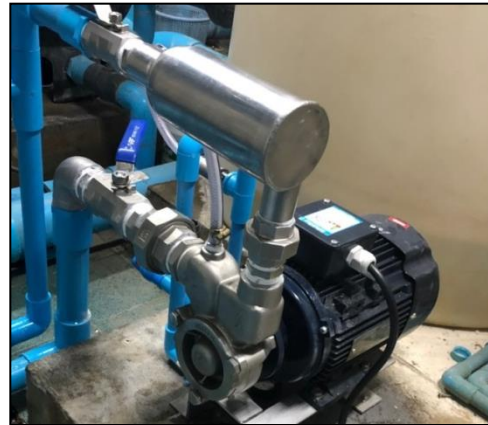
Ozone Generator 60 g./Hr.
