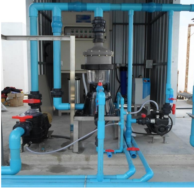
ระบบไอโซนบำบัดน้ำ Cooling Tower ร.พ.สินแพทย์
