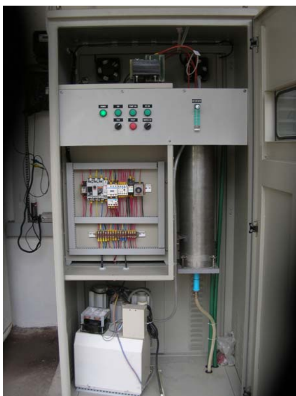
รูปที่ 4 แสดงอุปกรณ์ภายในของระบบผลิตไอโซน
