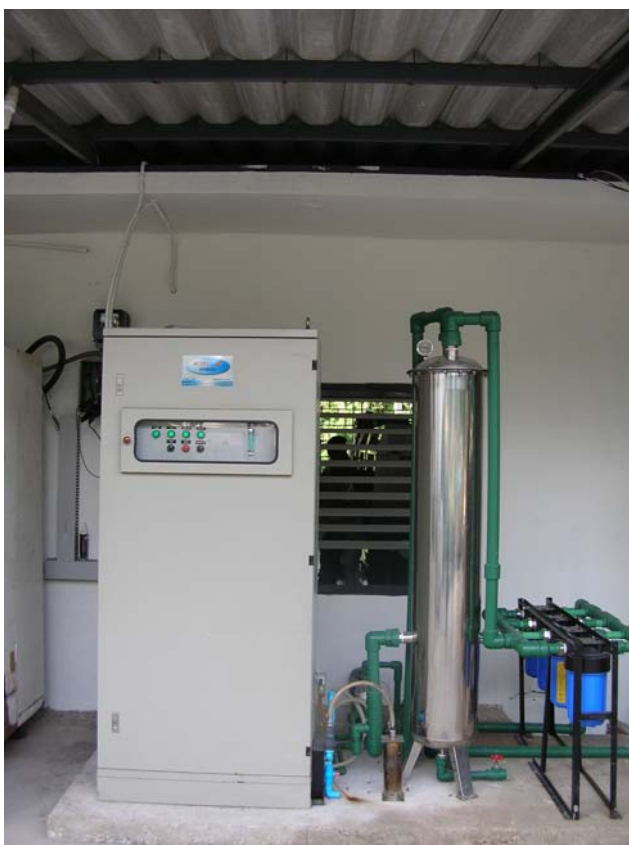
รูปที่ 3 อุปกรณ์ผลิตไอโซนและจ่ายน้ำไอโซนให้แก่เครื่องซักผ้า
